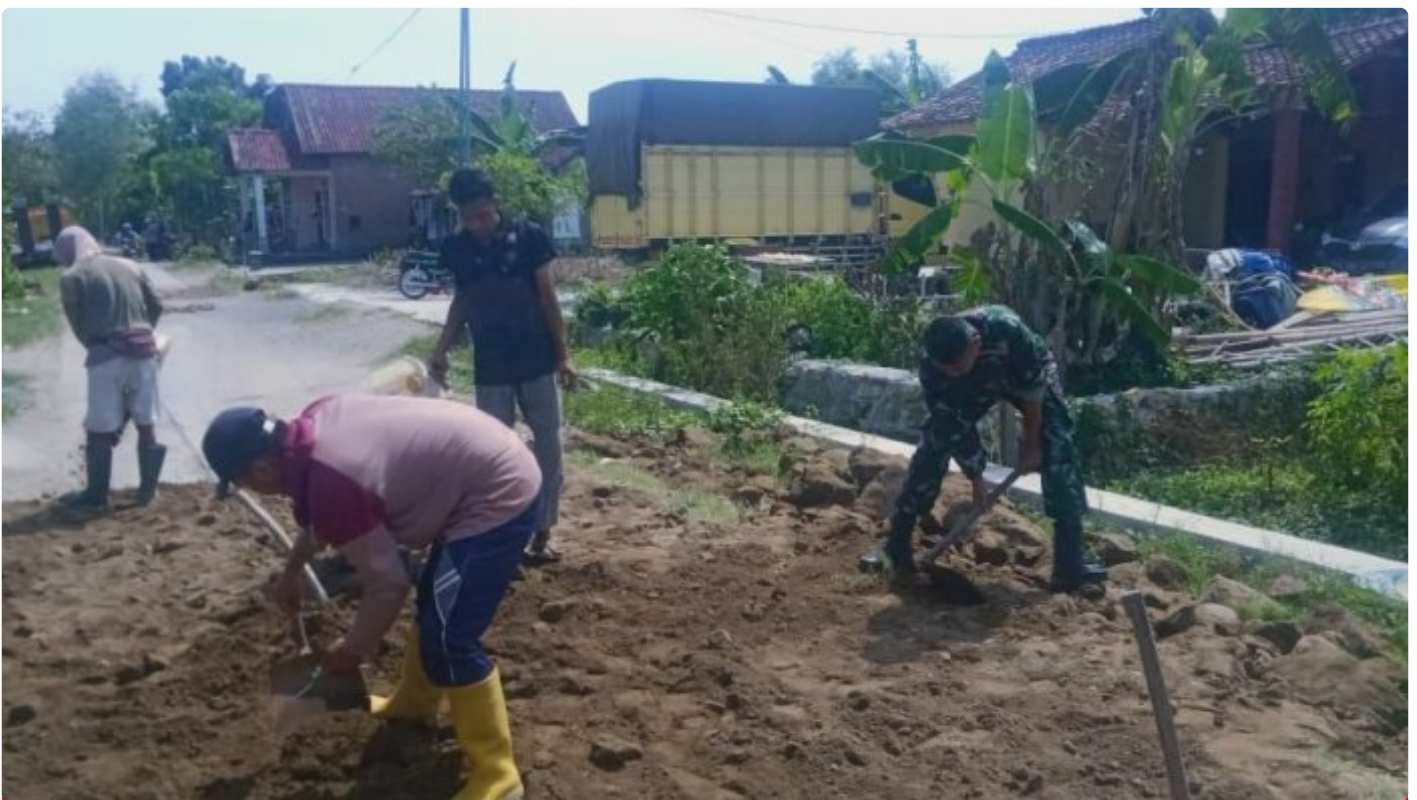
Anggota Koramil 12/Tegowanu Bersama Masyarakat Gotong Royong Meratakan Tanah Untuk Pematatan Pembangunan Jalan Dalam Pra TNI TMMD Reguler ke-117 TA. 2023
