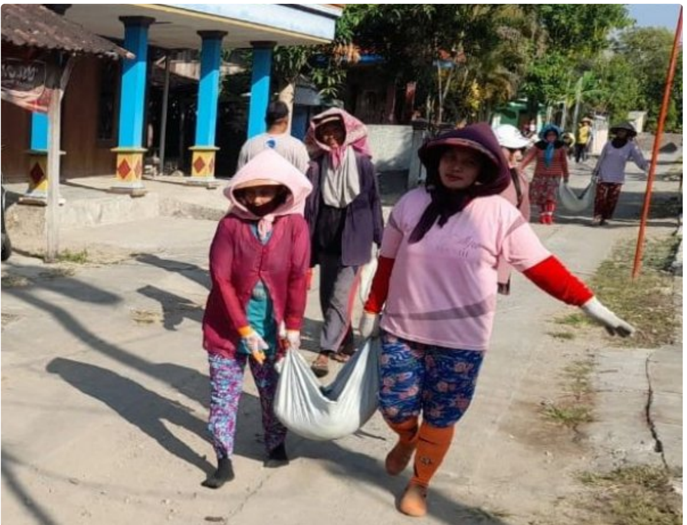
Ibu-Ibu Desa Cangkring Turut Membantu Pengecoran Jalan Program TMMD Ke-117
