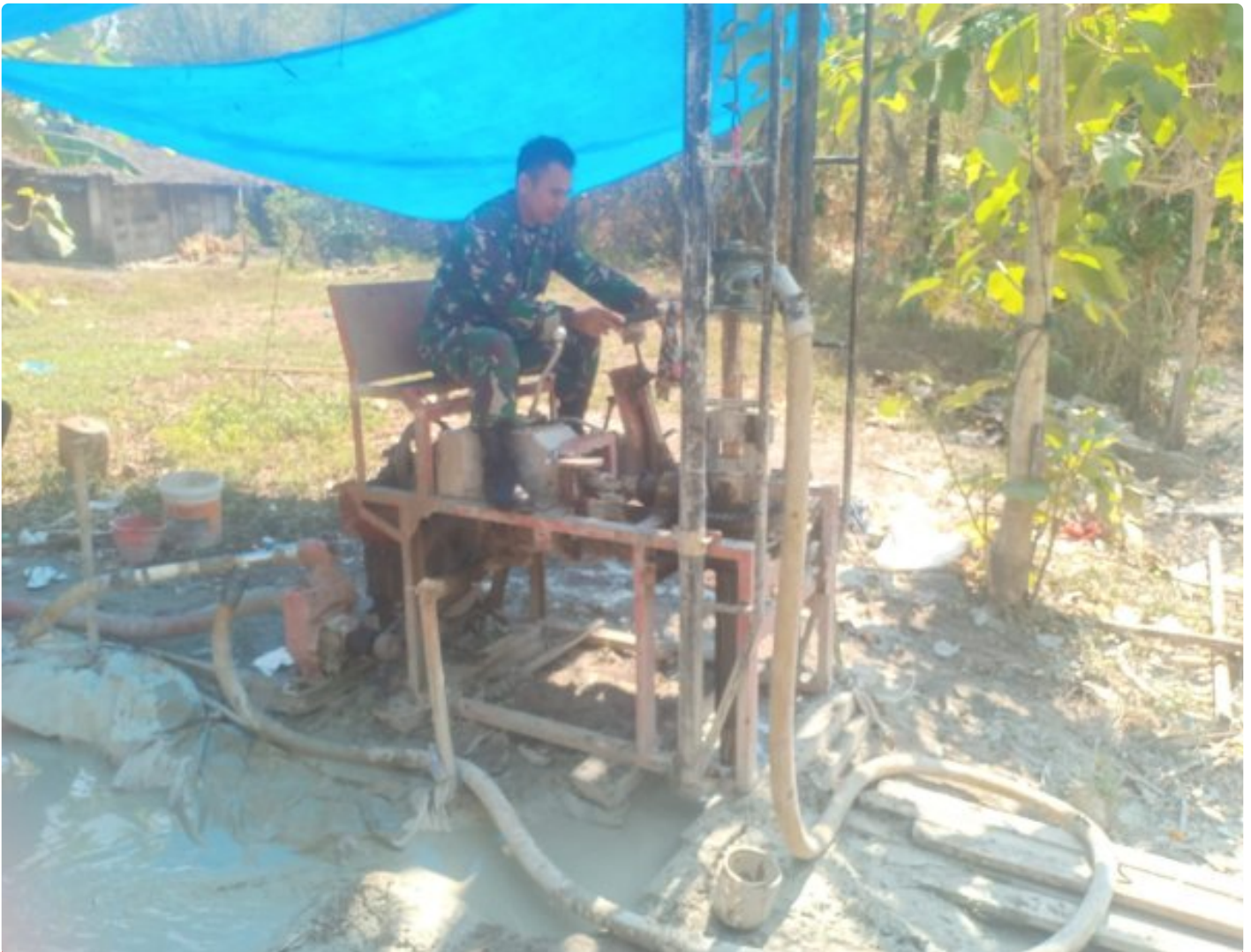
Proses Pengeboran Sumur Program TNI AD Manunggal Air Di Desa Jambangan Kecamatan Geyer
