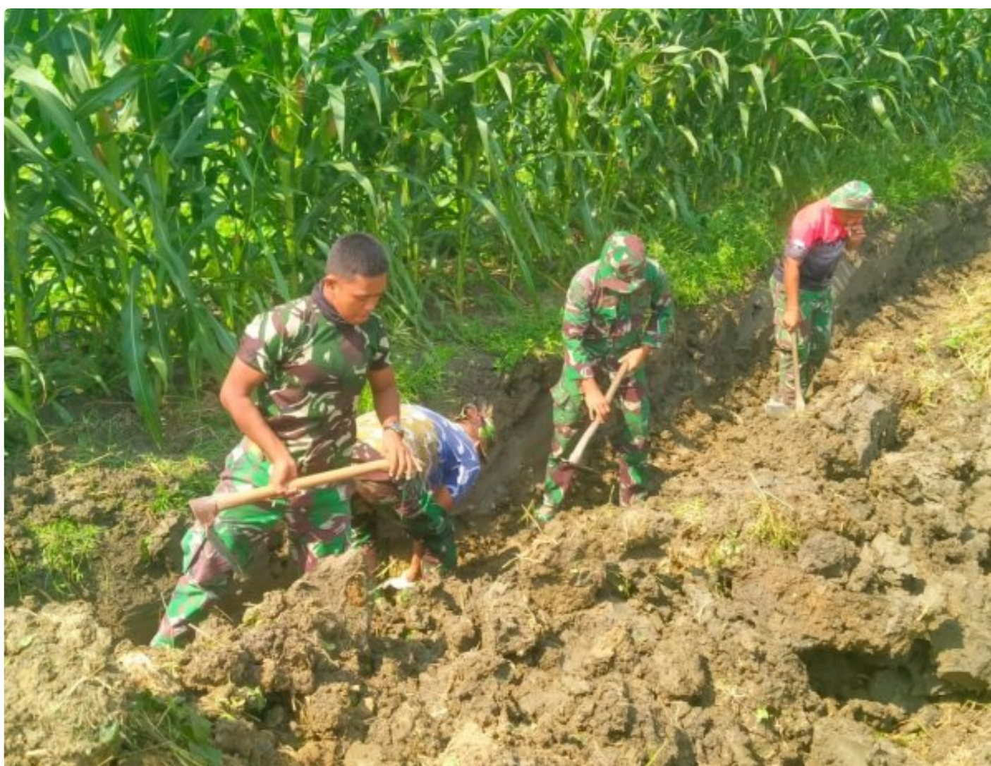
Satgas TMMD Kerjakan Sasaran Fisik Pembuatan Saluran Irigasi Tersier
